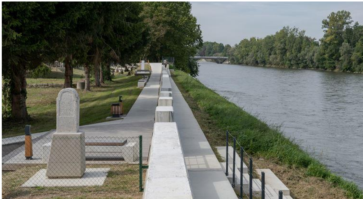
Slika 2: Nadvišan protipoplavni zid, Gornja Radgona
