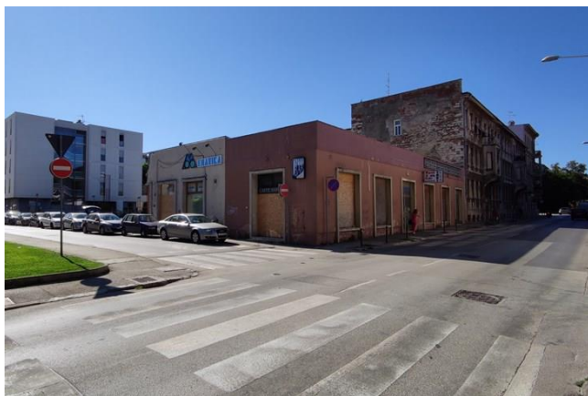
Slika 1: Analiza situacije pred rekonstrukcijo stavbe
