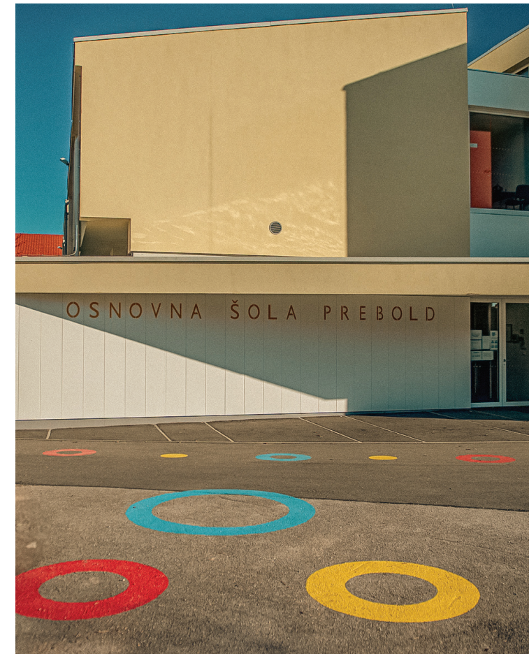
Občina: Prebold, Naziv projekta: Rekonstrukcija in dozidava Osnovne šole Prebold, Financiranje: Občina Prebold, sredstva MIZŠ, Vir fotografije: Ivan Lipičnik
