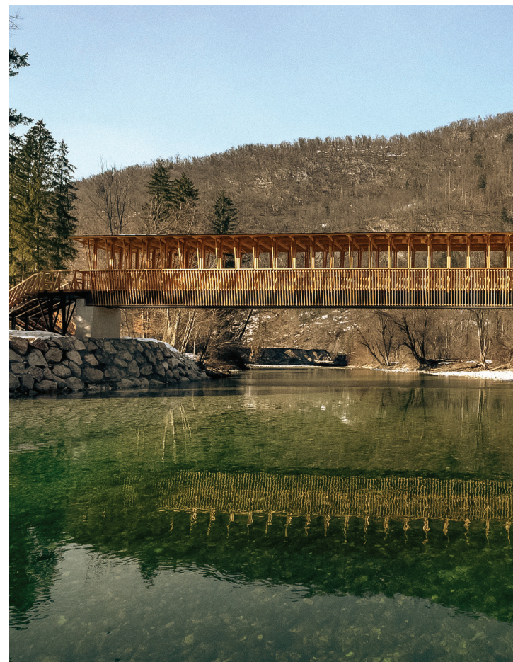
Občina: Bohinj, Naziv projekta: Izgradnja brvi na Rju in kolesarske povezave Kamnje-Bohinjska Bistrica, Financiranje: Občina Bohinj, Ekosklad, Vir fotografije: Občinska uprava Občine Bohinj
