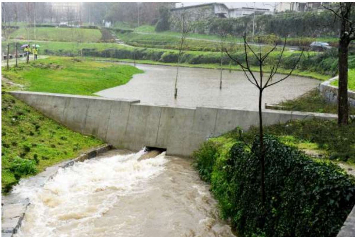
Bazen za padavinsko vodo, umeščen v krajino, z iztokom oziroma prelivom v vodotok
